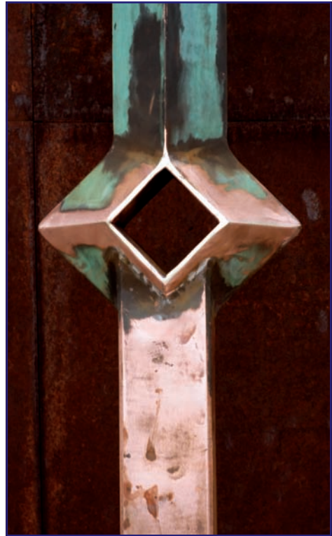
Die reparierte Bruchstelle
