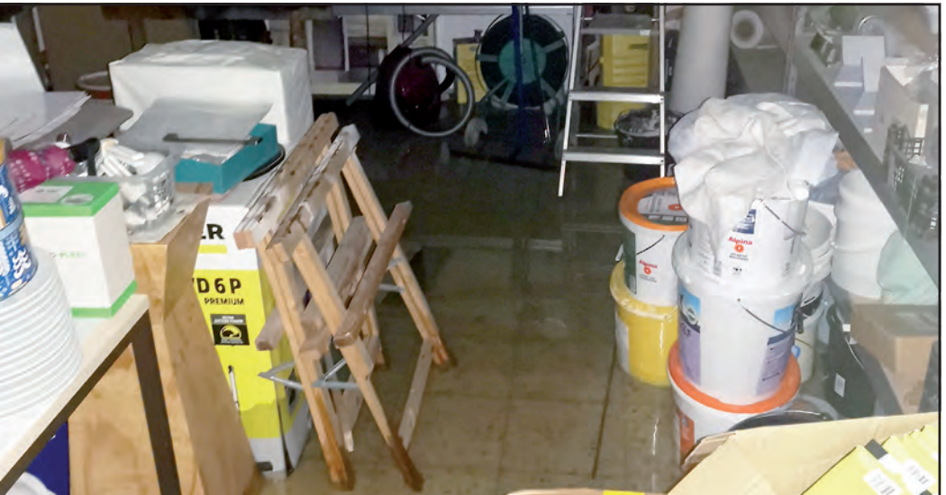
Im Werkstattkeller stand am 22.6.2023 das Wasser gut 15 cm hoch.
