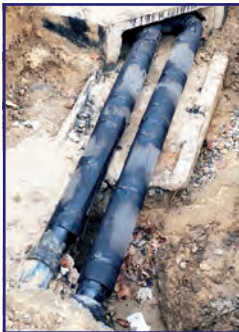
Die noch frei liegenden Rohrleitungen Foto Th. Roeseling
